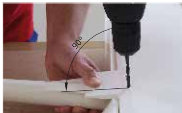
101. Vyvrtáme otvory Ø4,9mm... Drill holes Ø 4.9 mm ...
