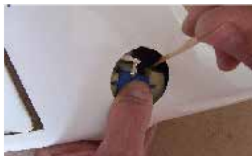
132. ...servo ustavíme, tak aby náhon výškovky byl v neutrálu, a servo zalepíme ... adjust servo, elevator drive must be in central position, glue servo to the fin.
